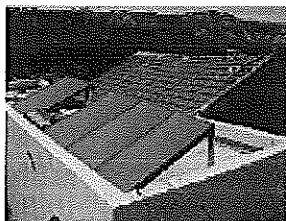
Derrière un mur acrotère en toiture
