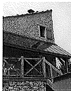
En couverture d'une pergola
