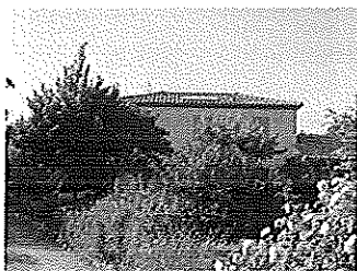
Discret en façade vue de la rue
